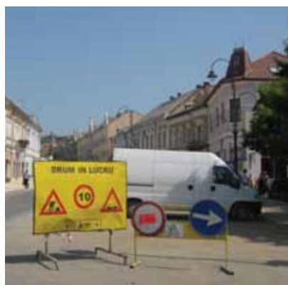
Vägarbete, vägarbete, överallt vägarbete...
