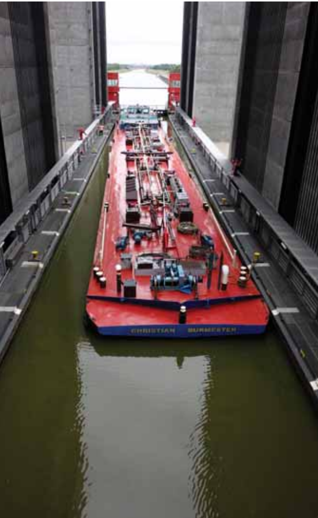
Nästintill ljudlöst lyfter "das Schiffshebewerk" ner och upp pråmar. Lyfthöjden är ca 40 m, vilket motsvarar 5-10 slussteg. Skeppsliften sparar därmed ganska mycket tid åt skeppare och rederier. Bilderna här visar en och samma flodpråm först förtöjd i den vattenfyllda och tillslutna plåtkanal som i sin helhet lyfts upp från den nedre hamnen, komplett med pråm och flodvatten, för att därefter släppa ut pråmen i full frihet i den övre hamnen.
