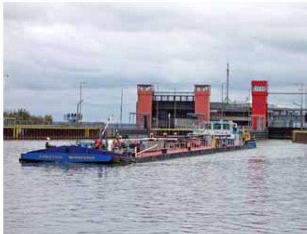
Nästintill ljudlöst lyfter "das Schiffshebewerk" ner och upp pråmar. Lyfthöjden är ca 40 m, vilket motsvarar 5-10 slussteg. Skeppsliften sparar därmed ganska mycket tid åt skeppare och rederier. Bilderna här visar en och samma flodpråm först förtöjd i den vattenfyllda och tillslutna plåtkanal som i sin helhet lyfts upp från den nedre hamnen, komplett med pråm och flodvatten, för att därefter släppa ut pråmen i full frihet i den övre hamnen.
